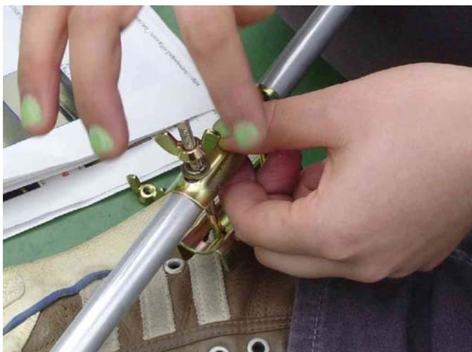
7. 先ほどマストにつけた印の位置にエレメントの中心が来るように反射器をUボルトで締め付けてマストにしっかりと取り付けます。
