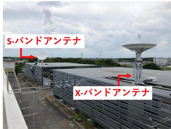
S-, X-バンドアンテナ(柏キャンパス)。国立大学改革強化促進補助金(H30)・超小型衛星開発拠点設置事業(H26-H30)にて整備。
